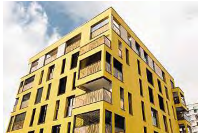
Von außen ist oft gar nicht zu erkennen, dass sich dahinter Mauerwerk aus Ziegel befindet. Hier ein Haus in Landshut mit abwechslungsreicher Fassadengestaltung.
