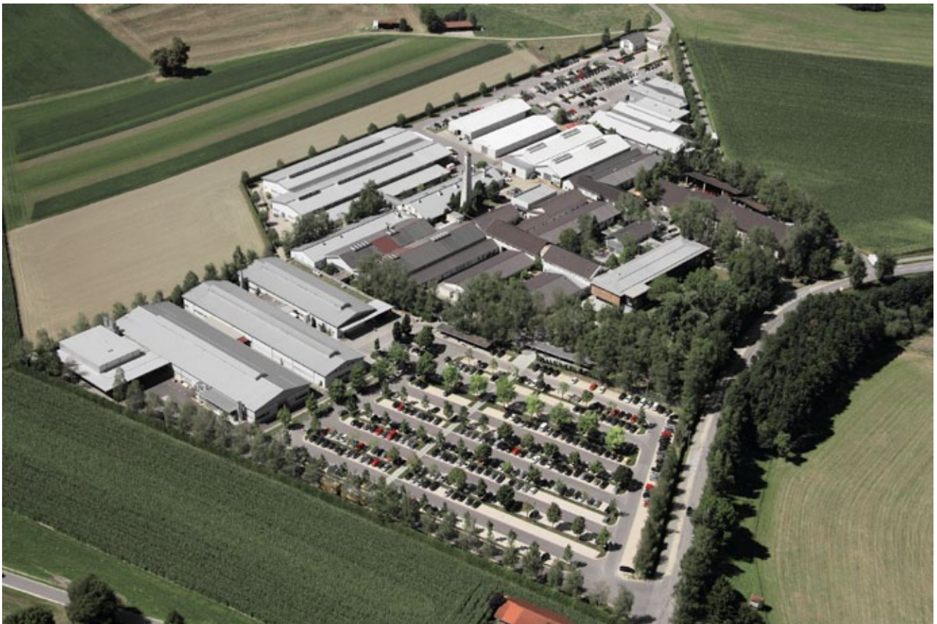
Vom Stammsitz im oberbayerischen Fridolfing werden täglich zwischen 100 und 300 Sendungen verschickt. Mit "Monitoring & Alerting" ist der Sendungsstatus jederzeit abrufbar.
